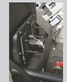
mehanizam za zaštitu kotla od povećanja pritiska u ložištu
